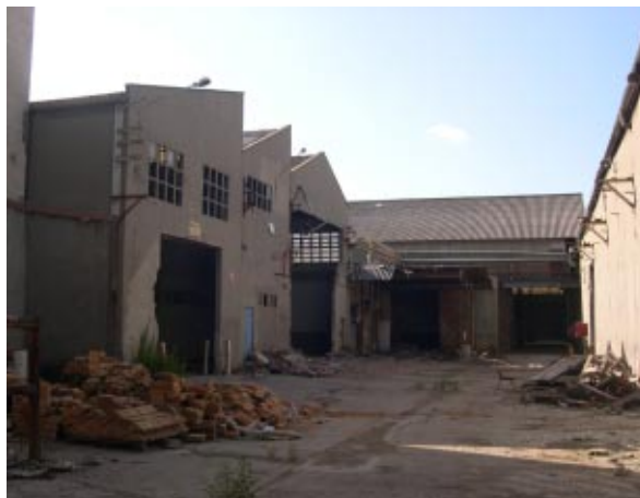
Antes del desamiantado.
