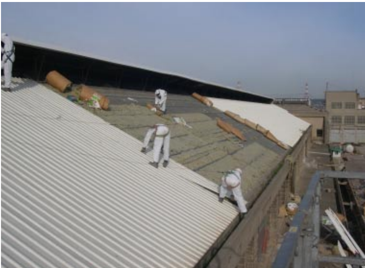
Los trabajadores con los epi's adecuados para el desamiantado.
