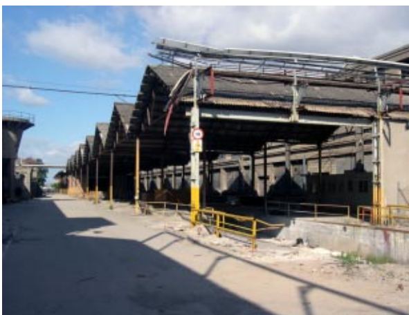
Antes del desamiantado.
