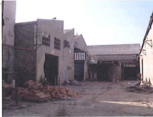
Antes del desamiantado.
