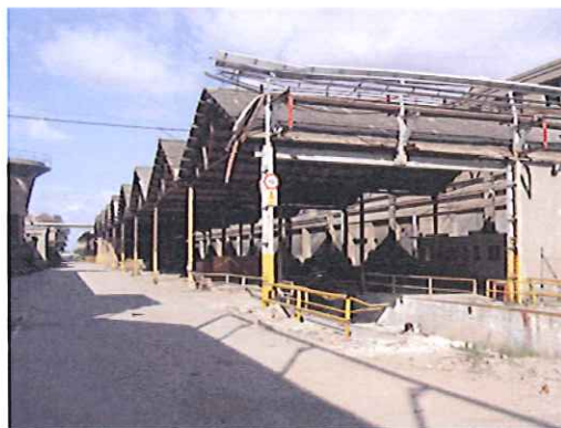
Antes del desamiantado.
