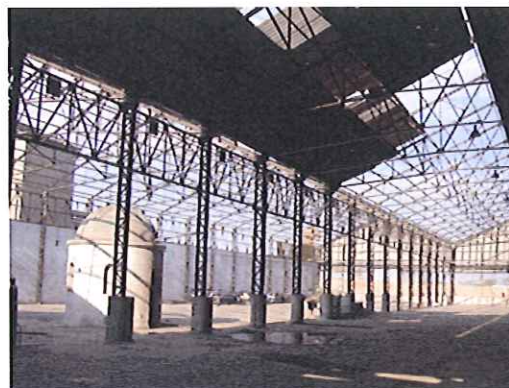
Después del desamiantado.
